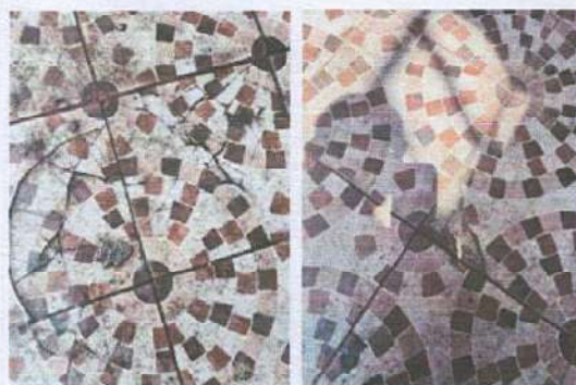
FOTO 8: Sustitución de piso cerámico quebrado.
